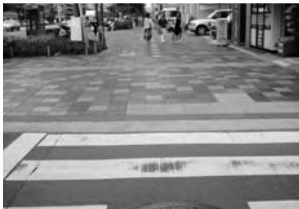
1センチに設定された横断歩道と歩道の段差（御池通り） One centimeter gap between sidewalk and pedestrian crossing (Oike-dori)
