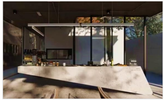
建設中のレストラン
