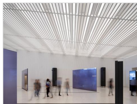
展示スペースのルーバー天井
