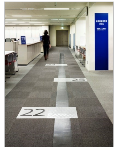
誘導タイルの設置後
