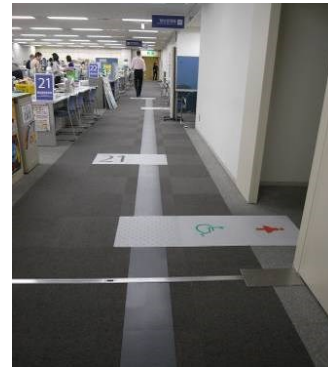
改修後の誘導タイル
