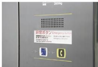
▲聴覚障害者専用の非常ボタンを設置したエレベーター(非常ボタン写真)
