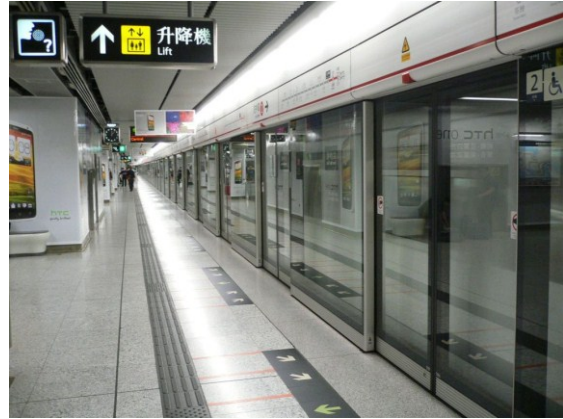
MTR（地下鉄）駅には完全密閉式のプラットフォームドアが設置されている
