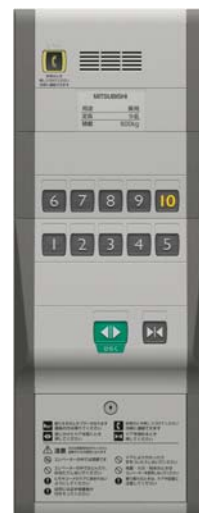
側面壁操作盤
