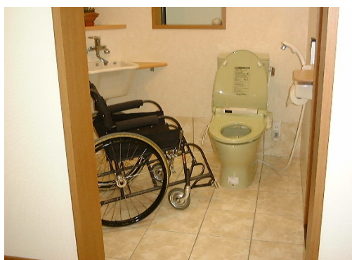
図 10 車いす使用者のためのトイレ
